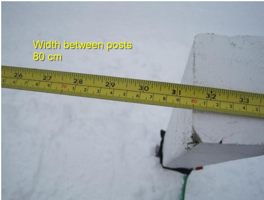
Les poteaux de départ doivent être installés à une distance de 80 cm l'un de l'autre et doivent être d'équerre à la ligne de pente. Les poteaux doivent être parfaitement à niveau et d'aplomb.
